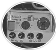
۴-۱- روی این بی‌میتال یک کلید تنظیم آمپر وجود دارد که قبلاً توسط کارخانه تنظیم شده است ولی برای کنترل و یا تنظیم مجدد می توانید آمپر نوشته شده روی پلاک پمپ را ملاحظه کنید و با افزایش حداکثر ۱ الی ۲ آمپر به آن، ولوم بی‌میتال را تنظیم نمایید.
