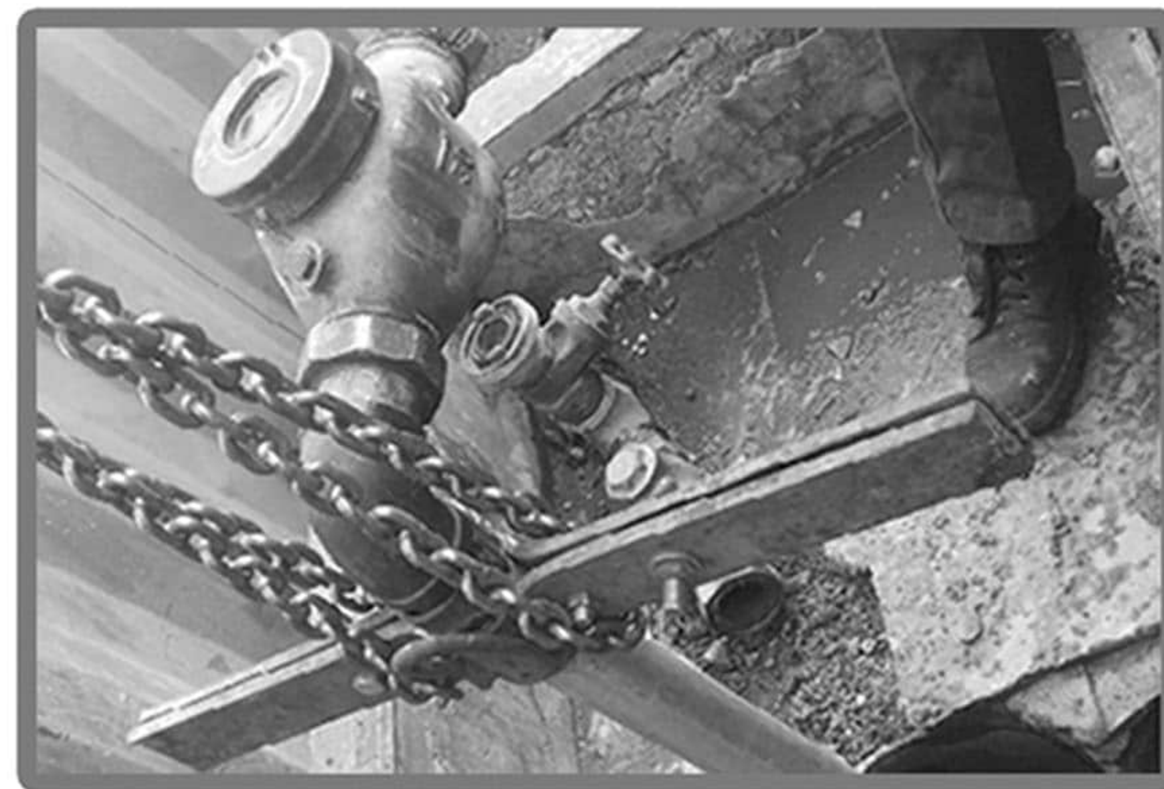
۱۳ - نصب کرپی نگهدارنده پمپ
