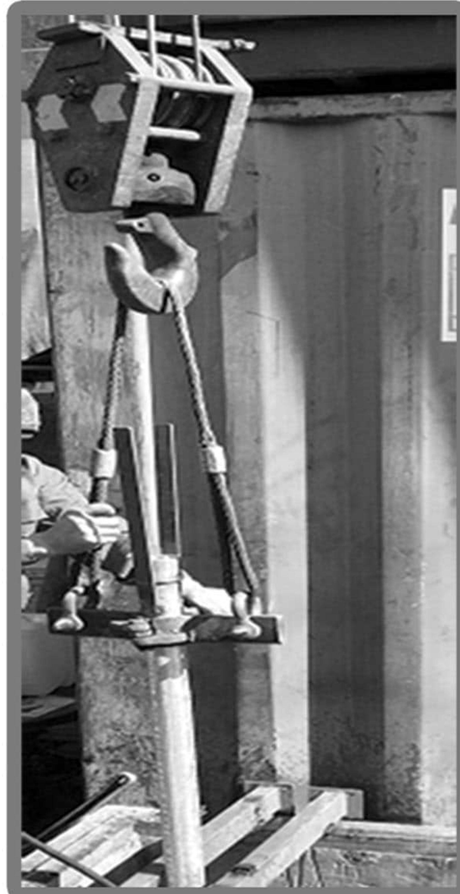
۷- انتقال لوله به همراه پمپ به داخل چاه
