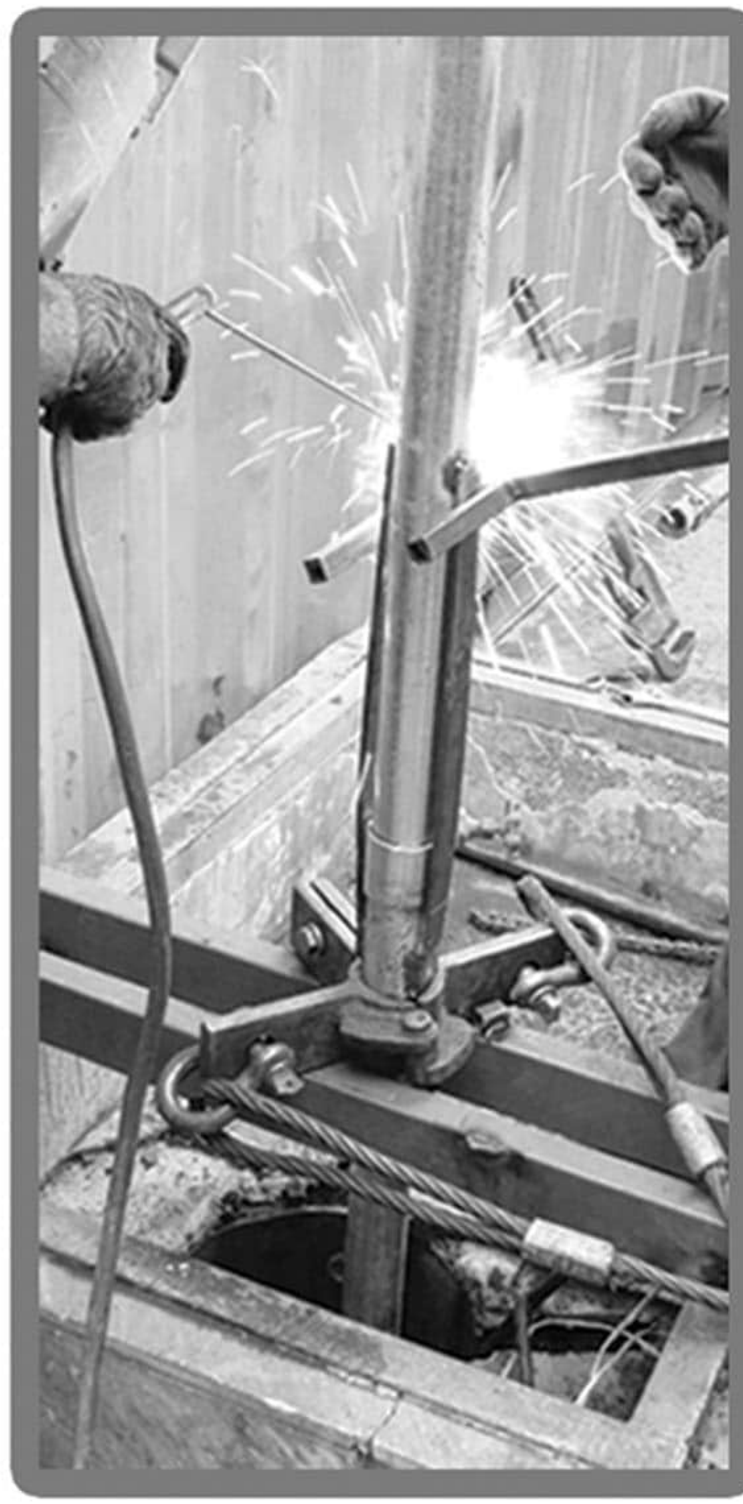
۱۰ - جوشکاری تسمه برای ایمنی بهتر
