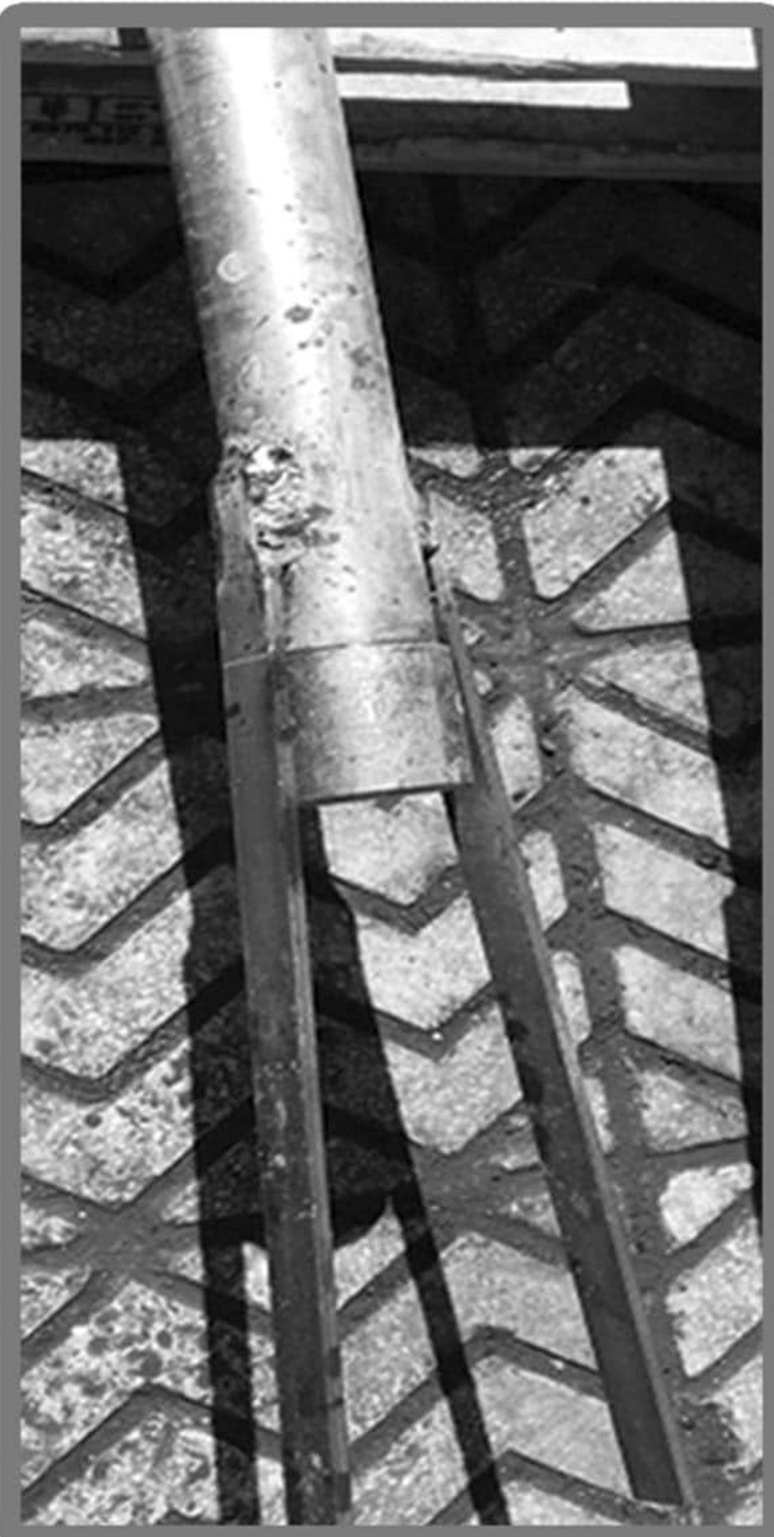
۸- آماده سازی لوله های اضافی قبل از انجام کار
