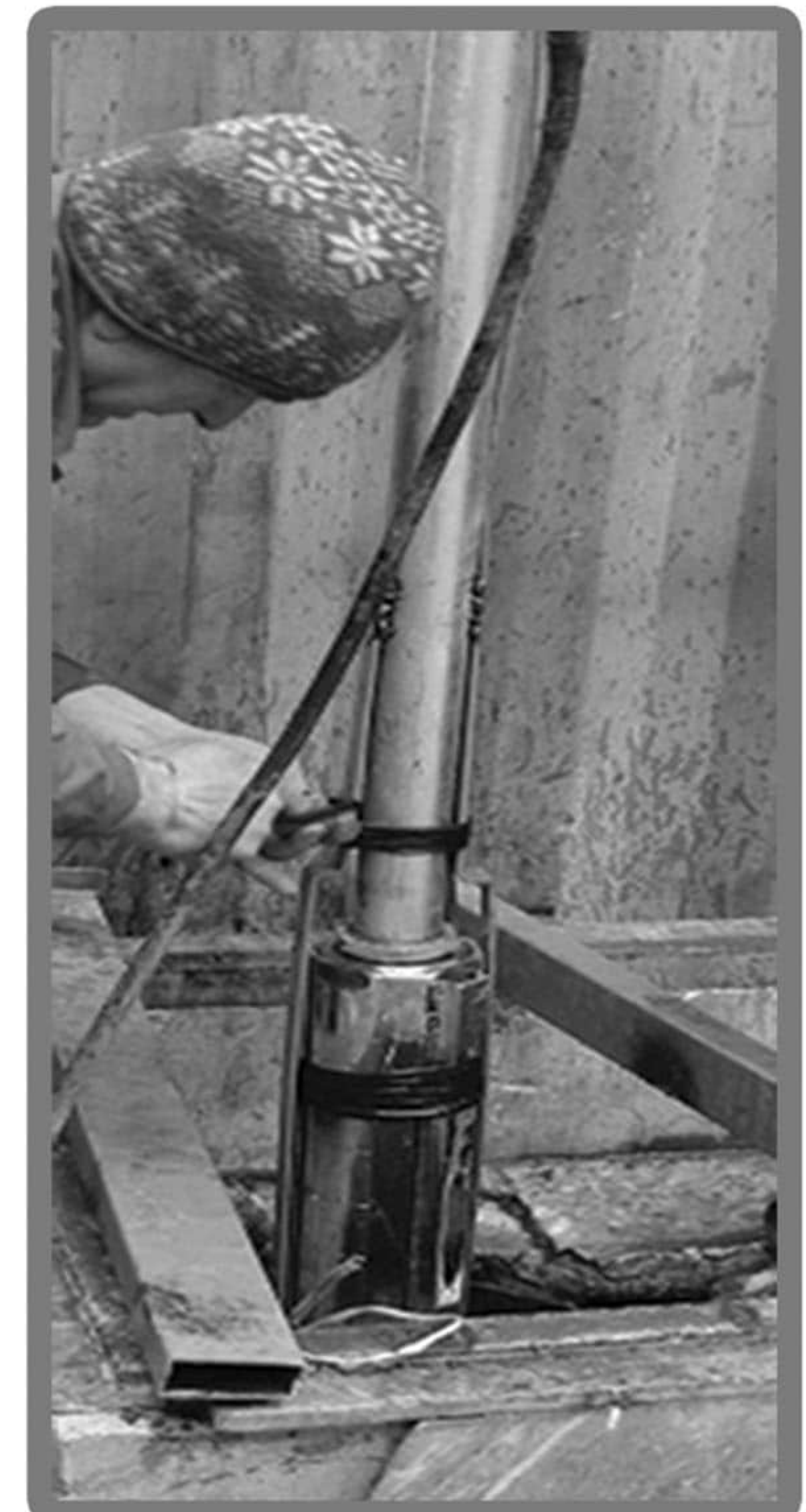
۶- بستن بسط لاستیکی برای نگهداشتن کابل
